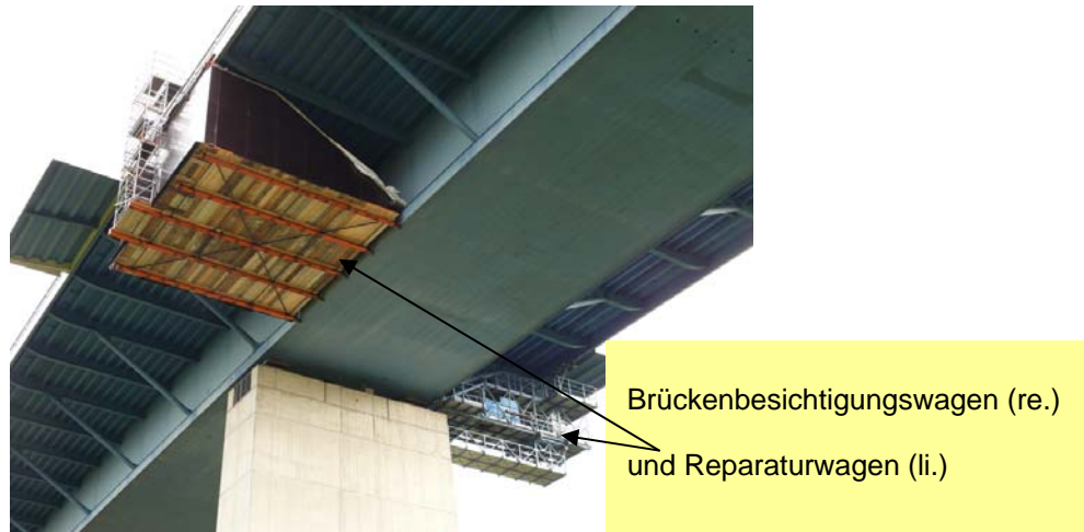
Abb. 3. Brückenbesichtigungswagen und Einhausung zur schweißtechnischen Sanierung eines Risses.
